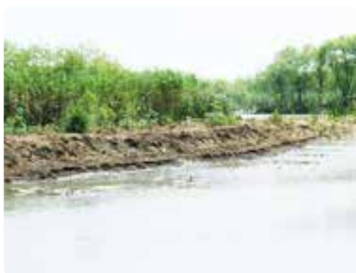
三山岛加固并改造的缓坡湖岸，减缓水流的冲刷力和增加水生生物多样性
